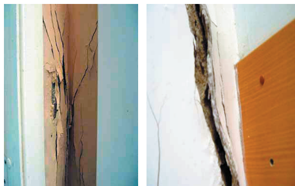
Рис. 2. Биоповреждения, образовавшиеся после 2 лет некачественного ремонта
