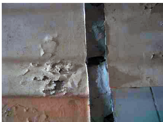
Рис. 1. Разрушенная гидроизоляция и элементы нарушенной структуры материалов
